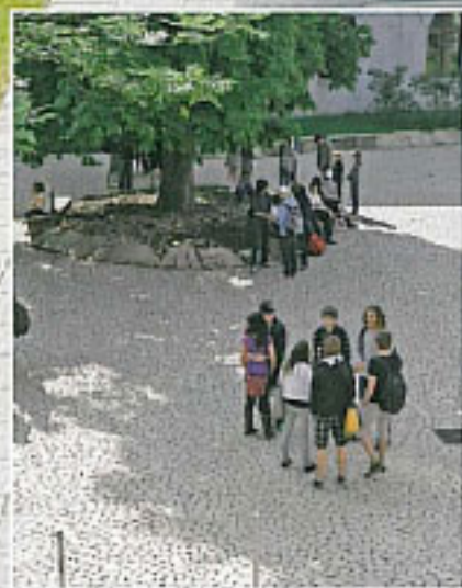
Pflasterfläche versickerungsaktiv in einem Schulhof, bei Bedarf als Parkplatz nutzbar
