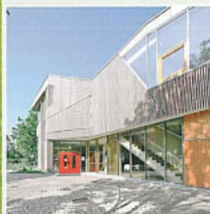
Versickerungsaktives Pflaster mit unregelmäßiger Struktur in einem Schulhof Foto: Braun
