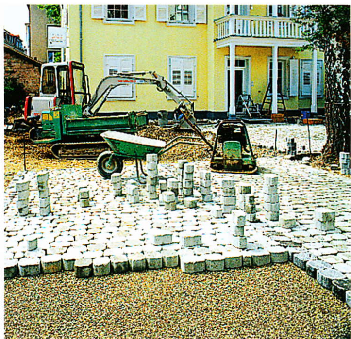
Versickerungsaktives Pflaster: Die Steine werden verlegt und Fugen gefüllt.
