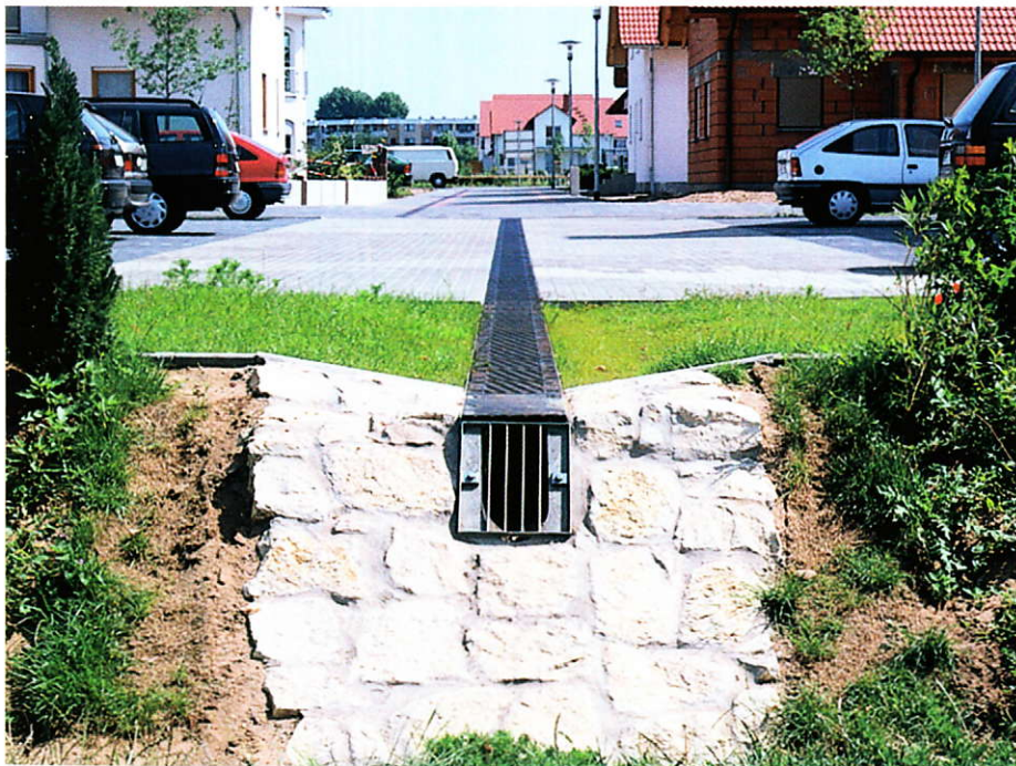
Regenwasserzulauf durch offene Rinne in eine bewachsene Sickermulde. Der oberflächennahe Zulauf ermöglicht eine flache Mulde.
