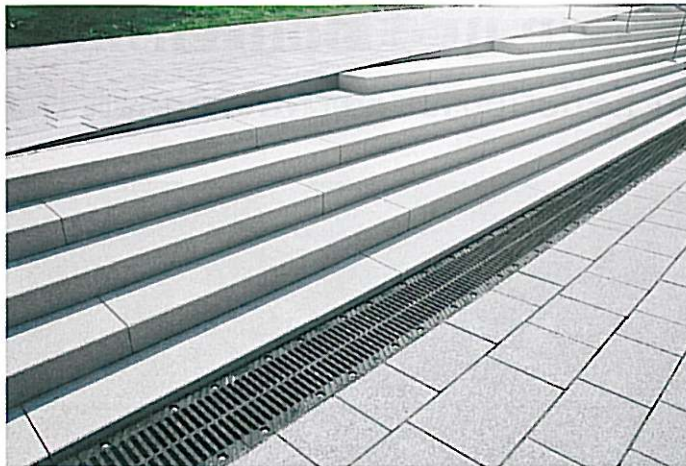
Rinne BIRCOsir, Oberflächenentwässerung der Messepiazza, Neue Messe Stuttgart
