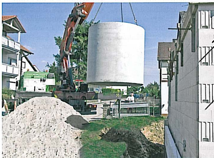
Versetzen des Regenspeichers ohne Umladen direkt vom Fahrzeug des Herstellers aus
