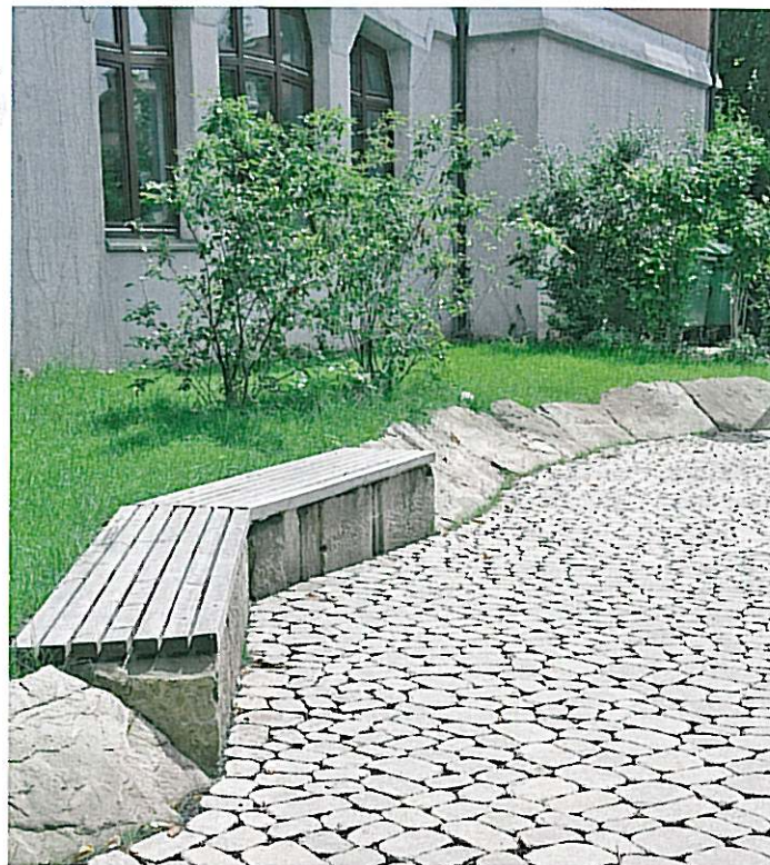
Versickerungsaktives Pflaster, unregelmäßiges Pflastersteinsystem im Schulhof
