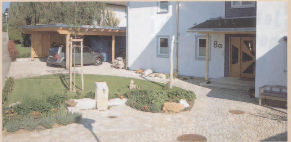
Während Einfahrt und Hof mit rechteckigem Pflaster befestigt wurden, erhielten der Vorplatz und die Hauszüge Beläge aus dem an gespaltene Kiesel erinnernden Pflastersteinsystem.
