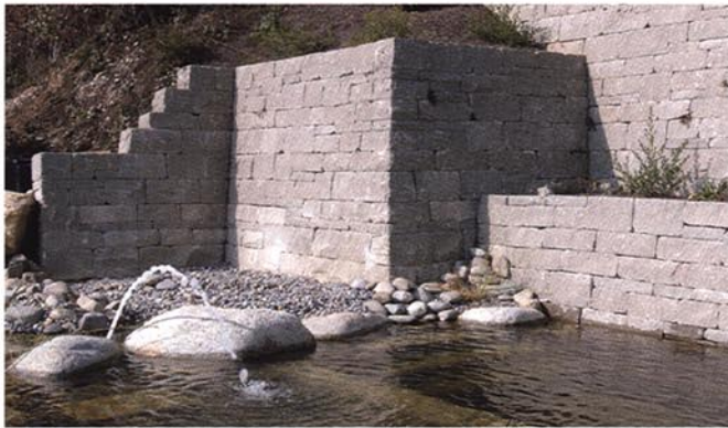
Wechselnde Schichten für ansprechendes Mauerwerk
