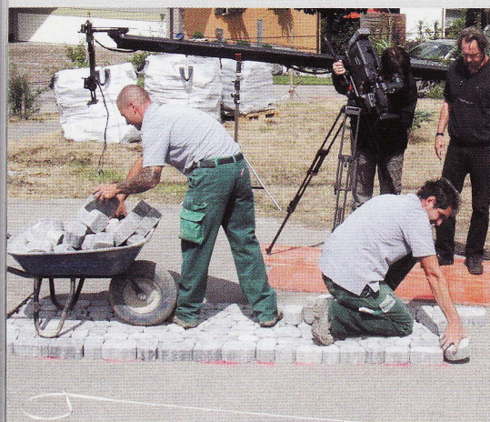
Das fachgerechte Verlegen des Arena-Pflasters wird im Film festgehalten. | Foto: Strahl.
